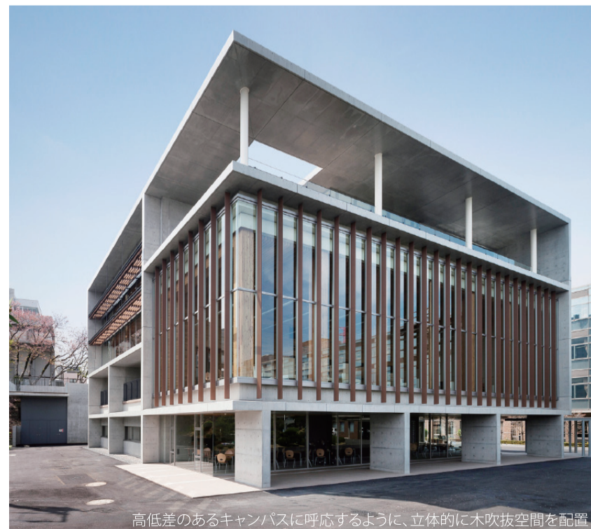
高低差のあるキャンパスに呼応するように、立体的に木吹抜空間を配置
