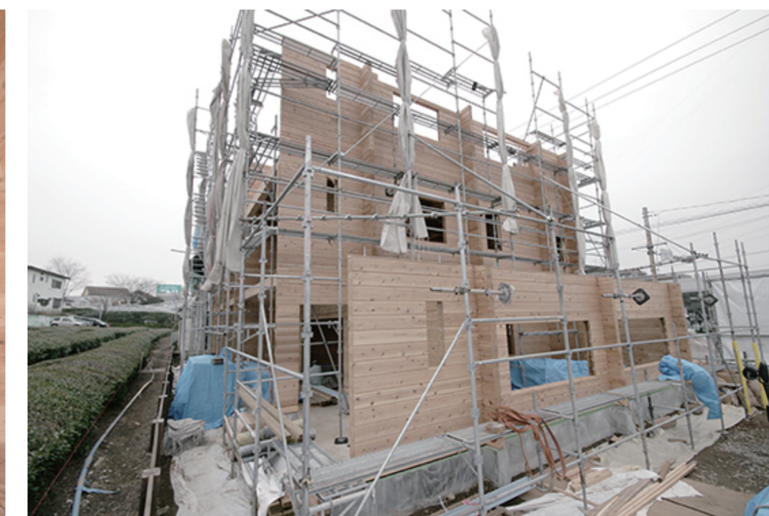
ログ組上げ工事
