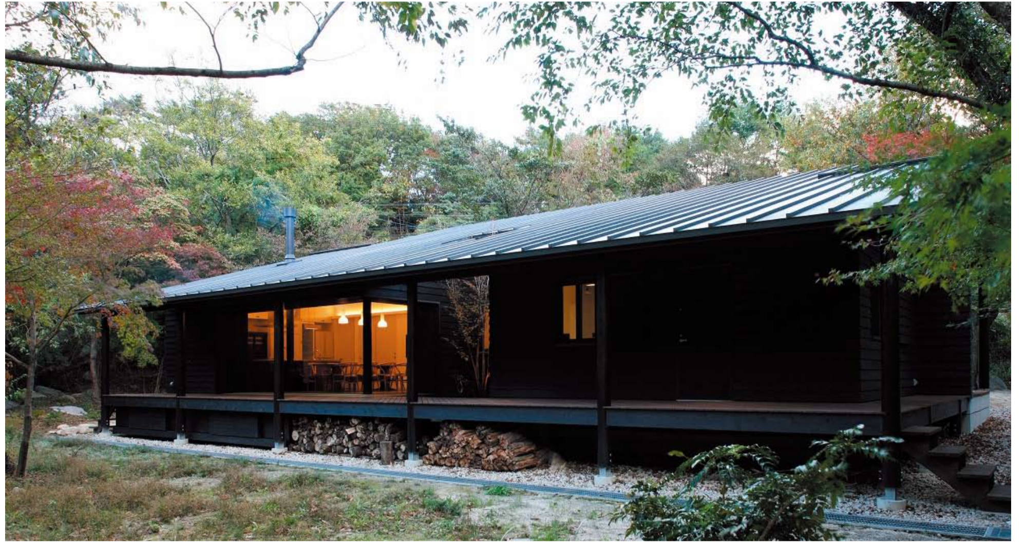
南西より建物を見る。
