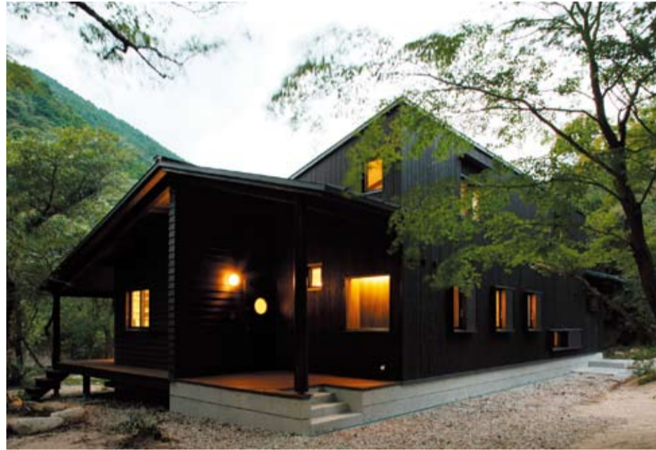
南東より建物を見る。
