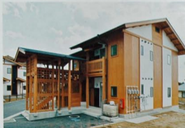
3号棟2階建て部分北西側
