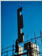
集成材パネル建て方
