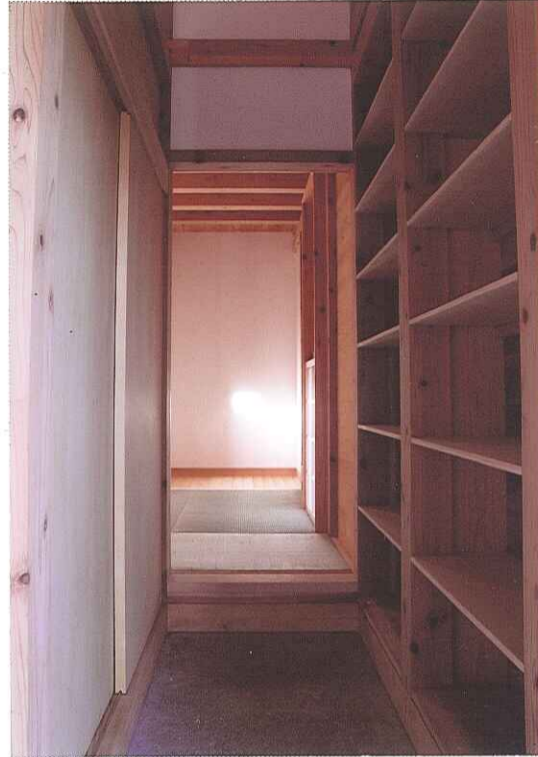
玄関から和室をみる 玄関・水回りの床は豆砂利入りセメント研ぎ出し仕上げ
