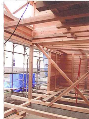
落し板を入れながらの建て方 構造材はすべて4寸角
