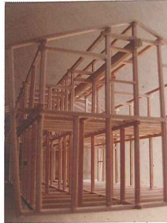
軸組み模型 一本の地棟以外はすべて4寸角
