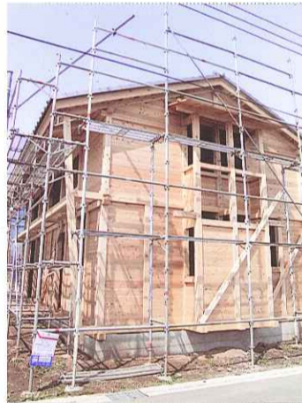
屋根工事了り時(落し板がみえる) 室内側の落し板はほとんどがあらわし
