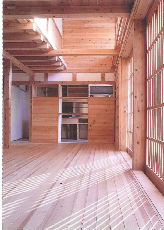
更に8分厚の木ズリをタテに張る ・ 落し板と併せ、耐震性能と防火性能を同時に満足する (壁倍率・防火構造認定取得)
