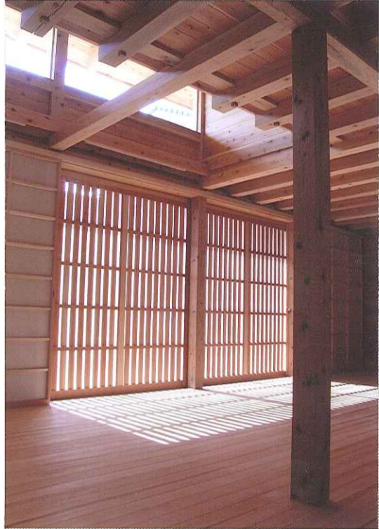
更に8分厚の木ズリをタテに張る ・ 落し板と併せ、耐震性能と防火性能を同時に満足する (壁倍率・防火構造認定取得)
