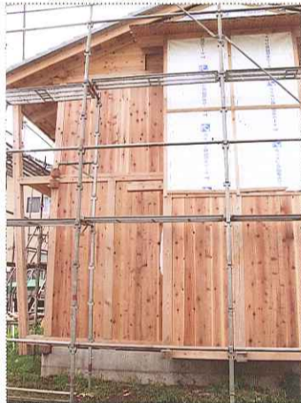
更に8分厚の木ズリをタテに張る ・ 落し板と併せ、耐震性能と防火性能を同時に満足する (壁倍率・防火構造認定取得)
