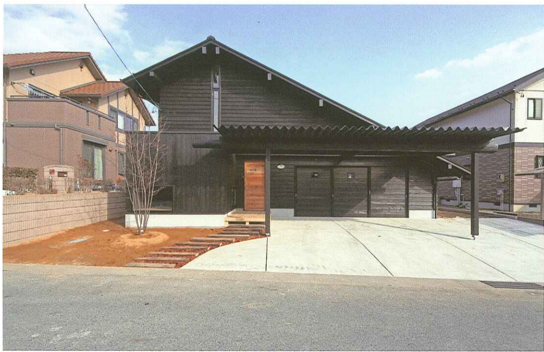
柱梁の構造材から、床・外壁の板材に地場産杉を使用
