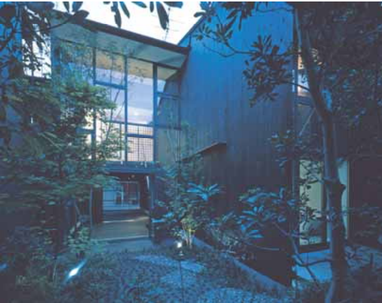
庭より建物を見返す：中央の壁は同じ仕上げのまま内部から外部へと連続する
