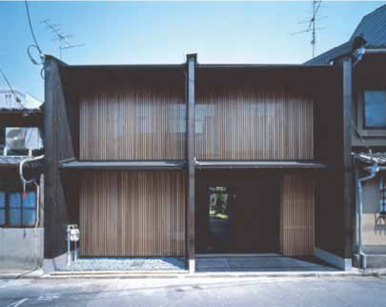
建物正面：両端2枚の集成材壁で延焼ラインをかわしている
