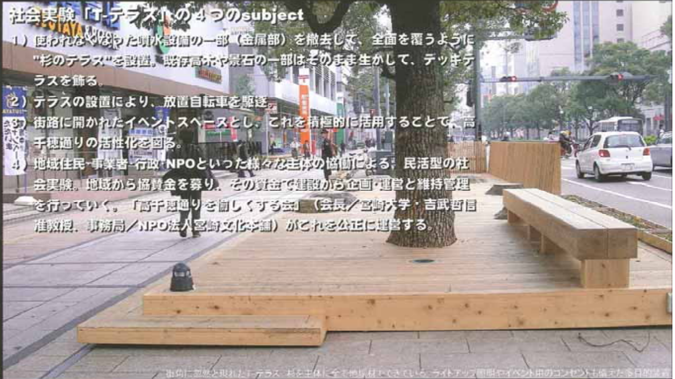
街角に開放と取れたT-テラス。杉を主体に全て地産材を採り、ライトアップ照明やイベント用のコンセントも備えた多目的活用
