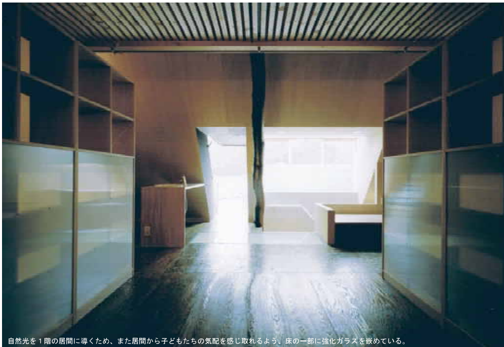
自然光を1階の居間に導くため、また居間から子どもたちの気配を感じ取れるよう、床の一部に強化ガラスを嵌めている。
