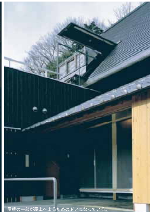
屋根の一部が屋上へ出るためのドアになっている。
