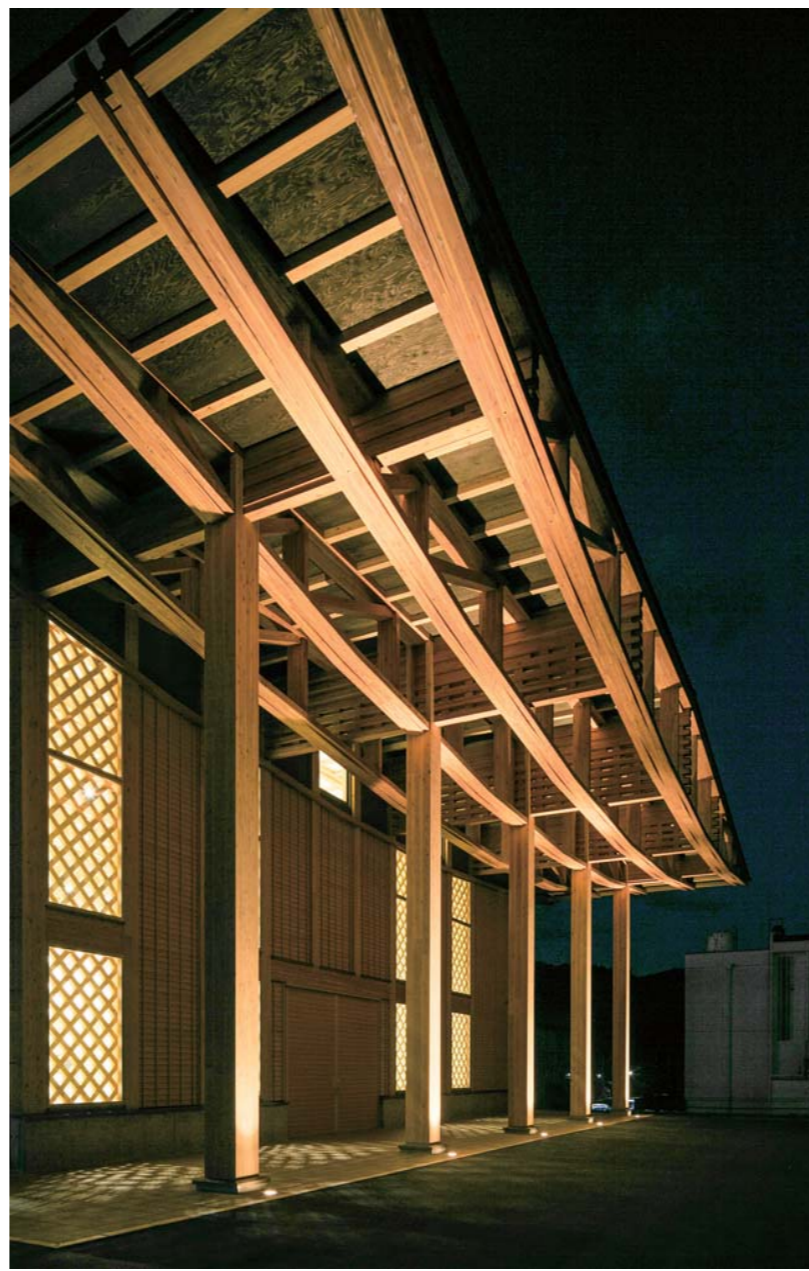
南側大庇：災害時の物資搬入口。重ね透かし梁で支えている。
