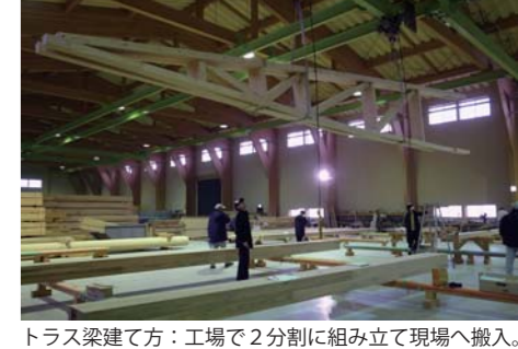
トラス梁建て方：工場で2分割に組み立て現場へ搬入。
