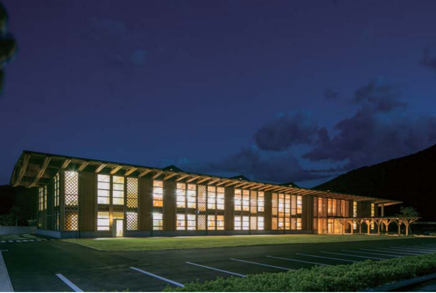
北西側夜景：採光と通風のためラチス耐力壁を用いている。
