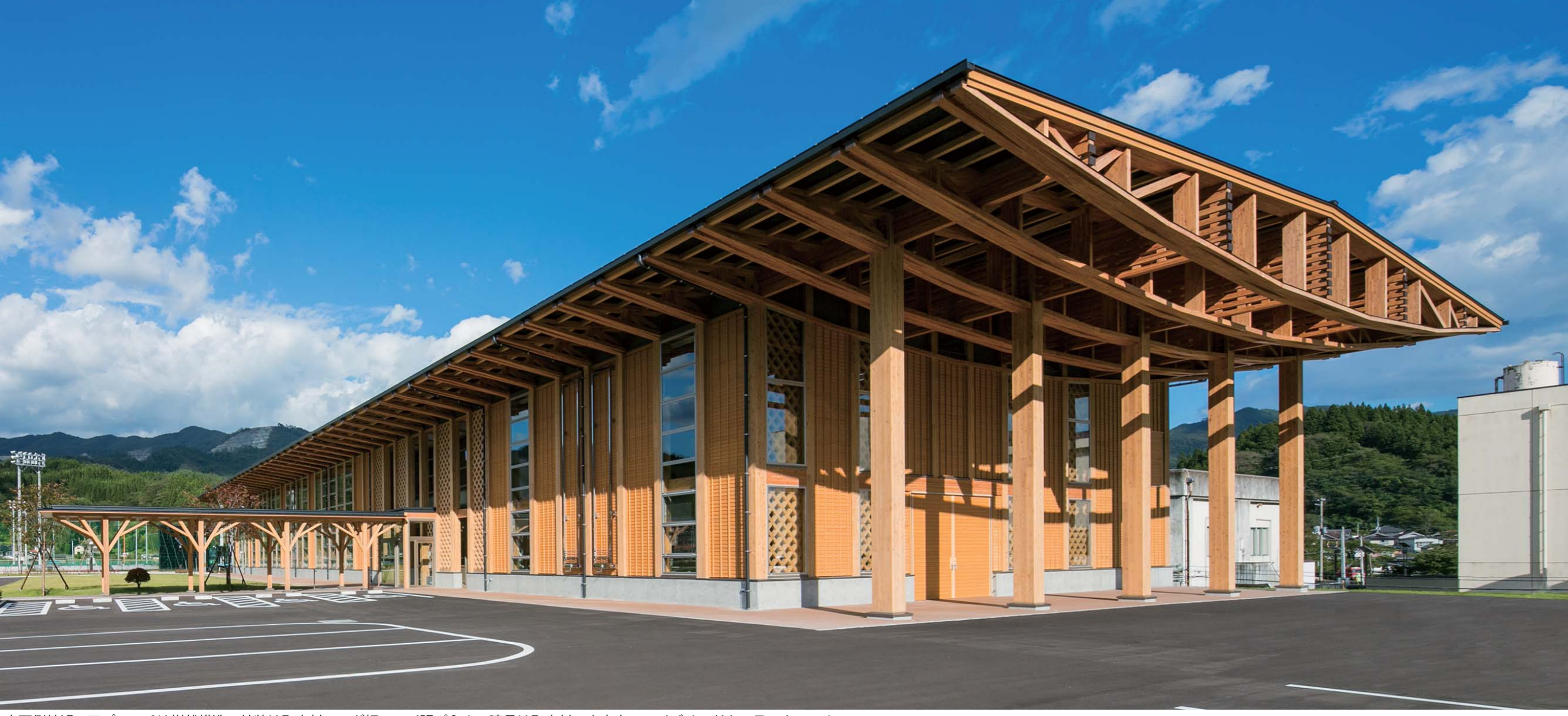
南西側外観：アプローチは樹状構造。外装は町産材のスギ板ヨロイ張りパネル。建具は町産材の木方立のハイブリッドカーテンウォール。
