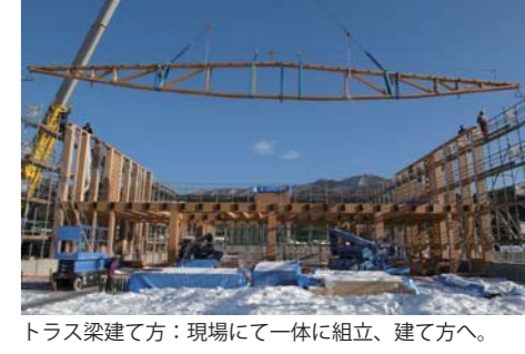
トラス梁建て方：現場にて一体に組立、建て方へ。
