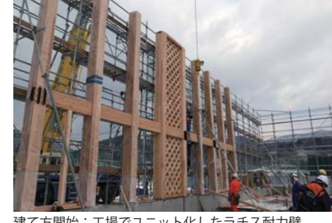
建て方開始：工場でユニット化したラチス耐力壁。
