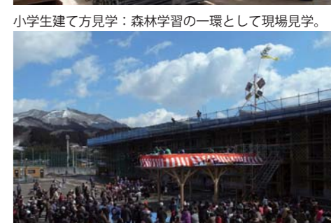
上棟式：町の伝統に即し、町民参加による餅まき。
