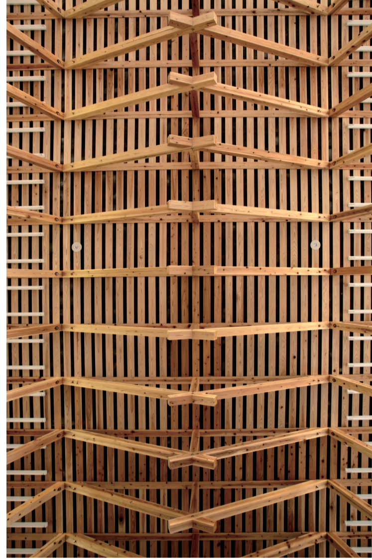
遊戯室天井の見上げ(4寸角材のトラス構造)
